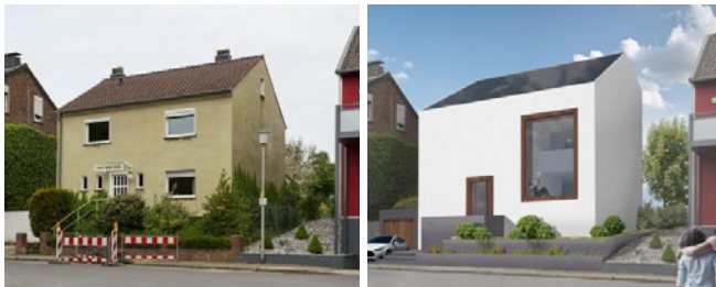
●●● Schroufstraße Sanierung Low-Tech
