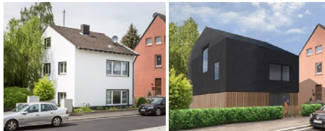
●●● Reuterweg Sanierung High-Tech
